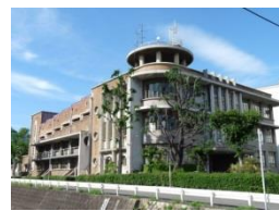
神戸市御影公会堂 1933 年竣工 築 84 年
