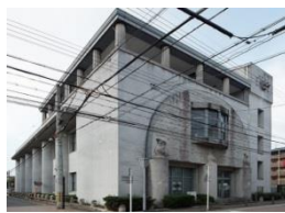
京都西陣電話局 1937 年竣工 築 80 年
