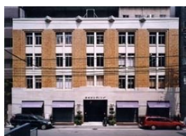
船場ビルディング 1925 年竣工 築 92 年
