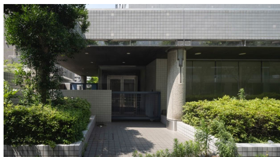
図 4.横断通路（改修前）（撮影：上田宏）
