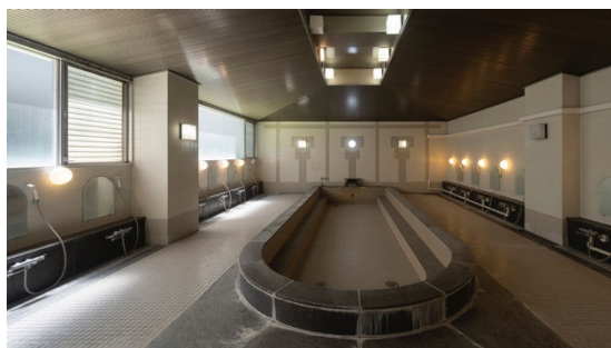
図 8.共用部（改修前）（撮影：上田宏）
