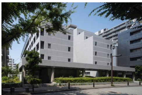
図 2.外観（改修前）（撮影：上田宏）
